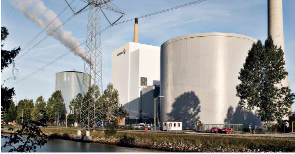
70,000 plus 15,000 m 3 hot water TTES at Fynsværket in Odense Denmark (Ramboll)
