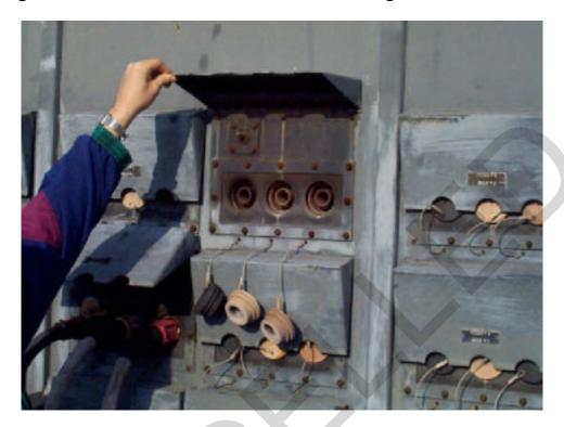
Figure 13-6. Newer Double-Deck Pier Switchgear
