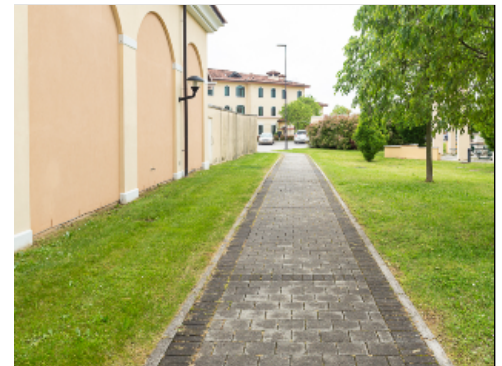
Pavers with Curb Edge
