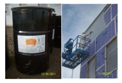
Fig. 9.6 Fluid-applied membrane
